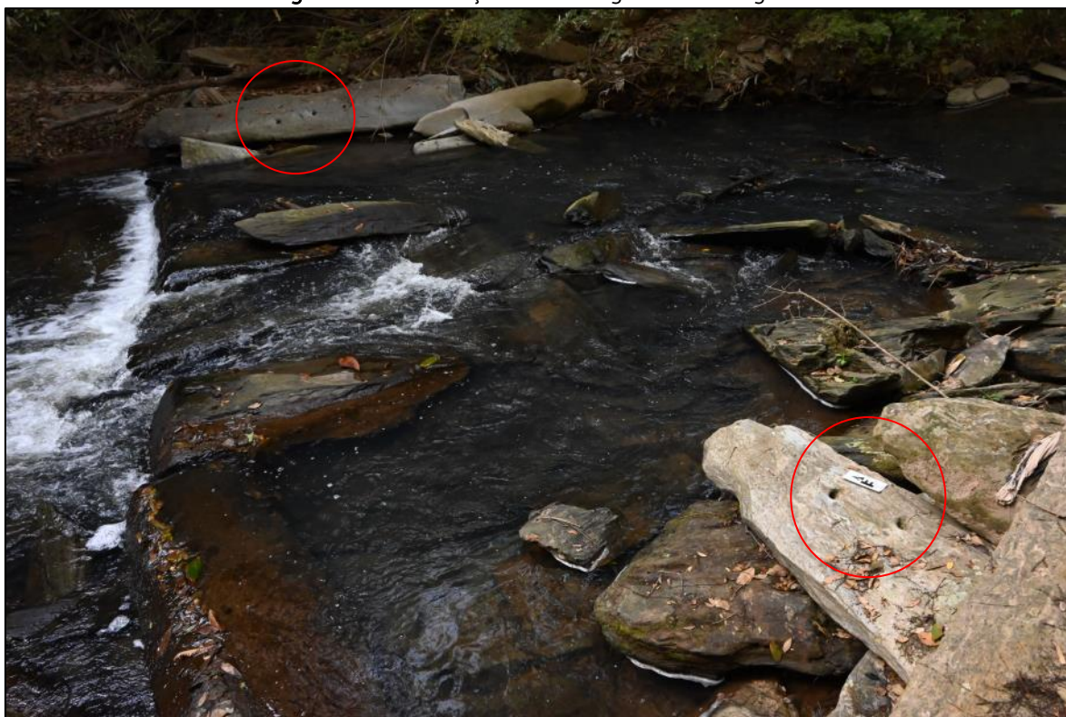
Figura 34 – Perfurações nas margens da barragem
