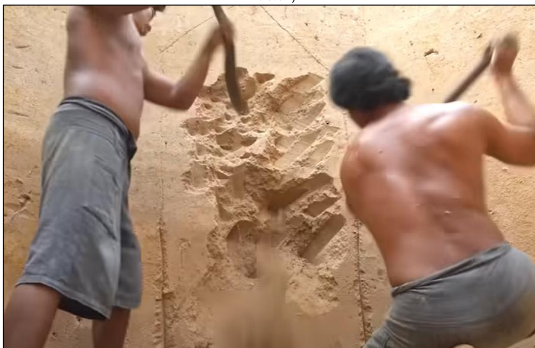
Figura 4 – Exemplo das marcas deixadas no suporte quando utilizando ferramenta com gume linear e ângulo de impacto próximo a 45^\circ . A cena do vídeo exemplifica bem as marcas deixadas no sedimento com faixas retangulares e/ou canaletas que indicam por onde a ferramenta passou. (BUILDER, 2020, m. 0:59)
