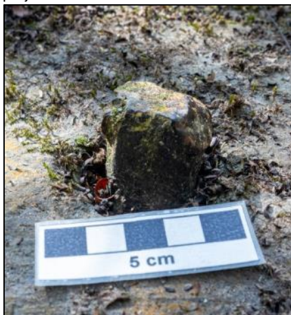
Figura 31 – Detalhe da peça de ferro cravada na rocha na lateral do canal escavado
